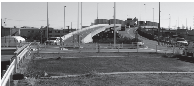
▲ガードレールで囲まれ未供用となっている鎌倉新橋
