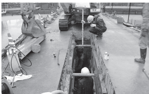
▶下水道工事(平島地内)
