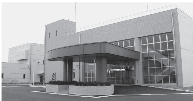
▶海部地域の下水処理を行う日光川下流浄化センター（上野地内）
