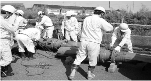
▶ 水中ポンプの稼働訓練
