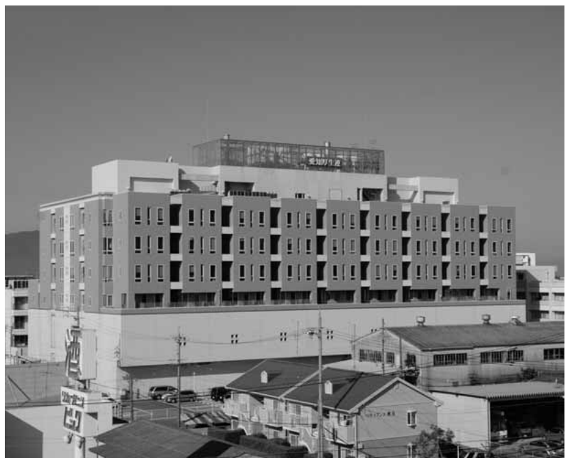
▲海南病院新病棟（平成15年2月完成）
