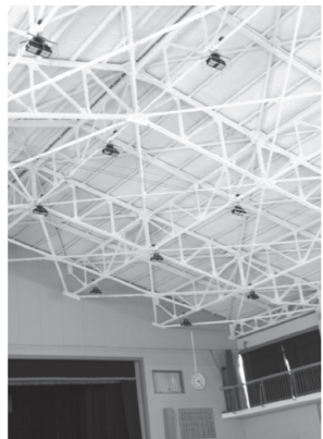
吊り天井撤去後の体育館
