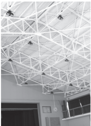
吊り天井撤去後の体育館
