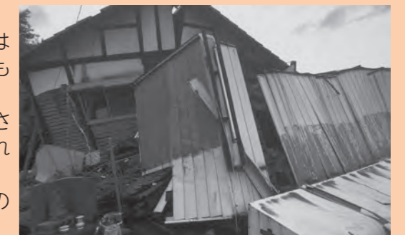
熊本県益城町の被害の様子
