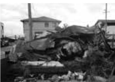
▲佐古木地区火災現場の現状
