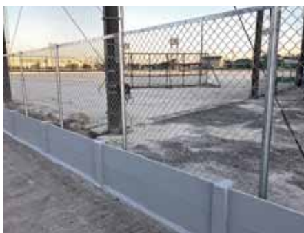
▲ブロック塀を撤去し、新たにフェンスを設置した文化広場
