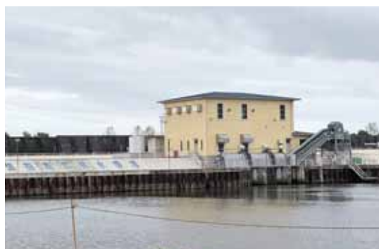
▲鍋田南部排水機場 (鍋田町地内)
