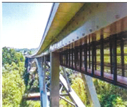
全長280m 高さ80mの 天龍峡大橋
