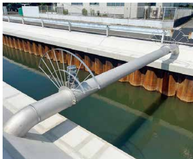
▲ 水道配水用ステンレス管添架現場
