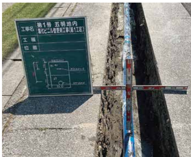
▲ 水道配水用ポリエチレン管布設現場
