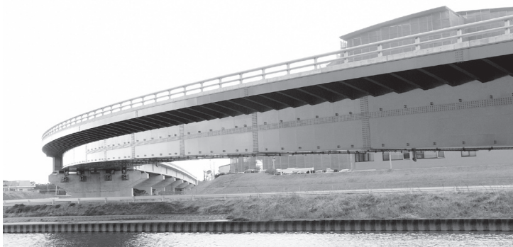
▶整備の進む鍋田ふ頭進入道路 (写真後方「八穂クリーンセンター」)
