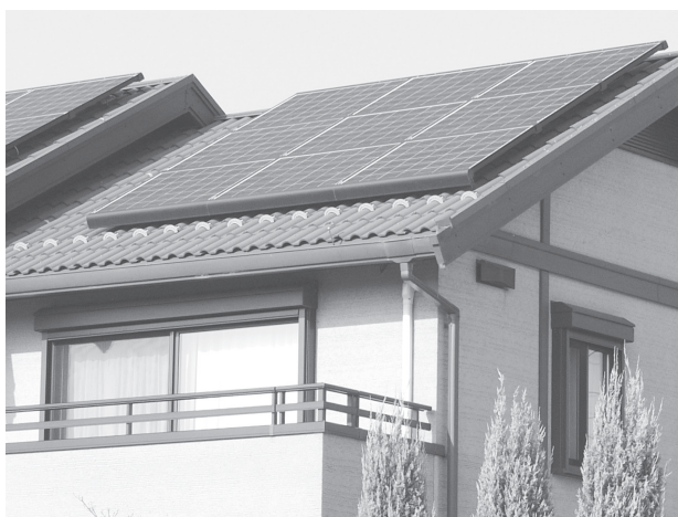
▶ 太陽光発電装置を設置した住宅
