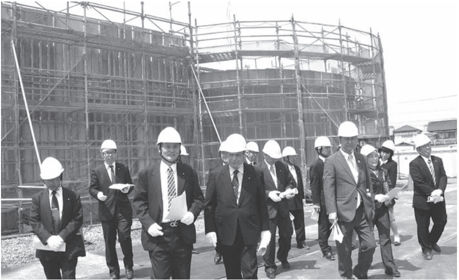
▶ 工事の進む(仮称)第2校小学校を 見学する議員【4月17日・平島町地内】
