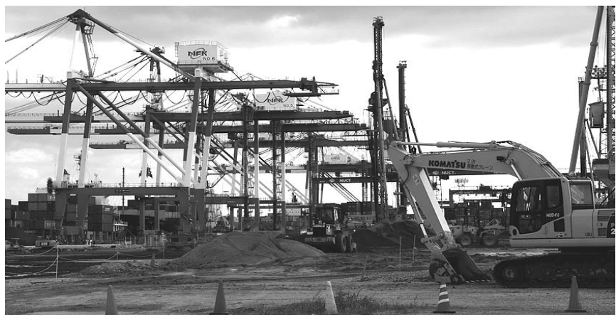
▲ 21年11月に着工した鍋田ふ頭第3バース(富浜地内)
