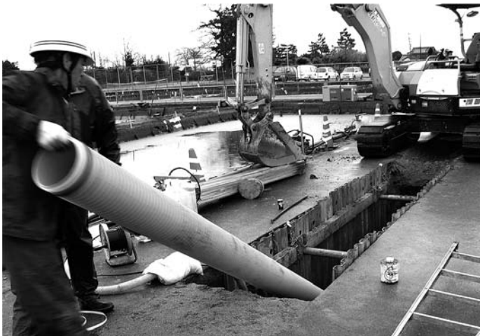
▶ 下水道工事（平島町地内）
