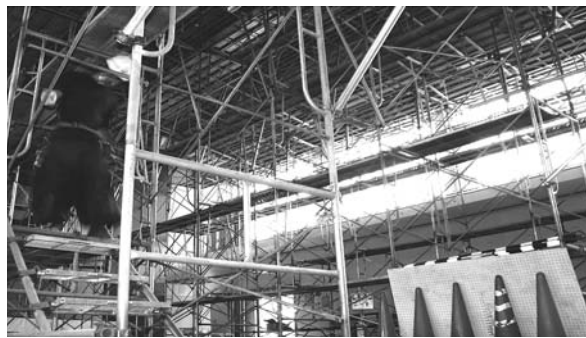
耐震工事中の栄南小体育館
