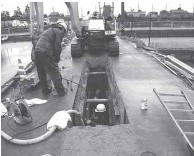
▶ 下水道工事(平島地内)
