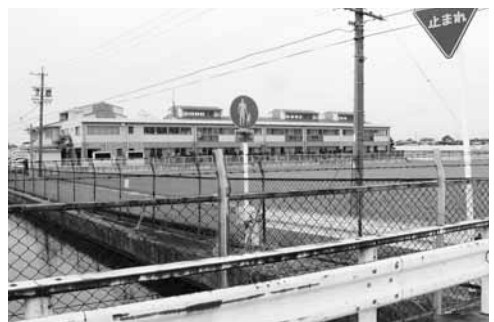
◀木曾川用水路のフェンス(森津地内)
