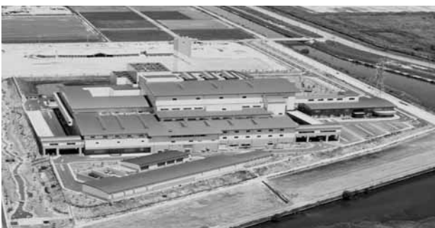
▶ 海部地区環境事務組合 八穂クリーンセンター
