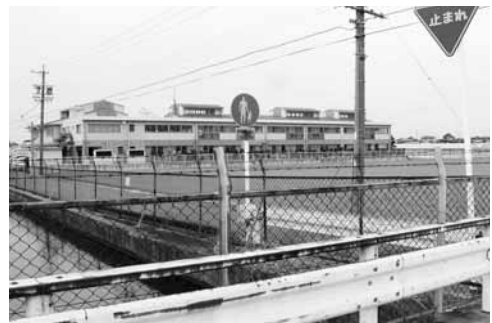
◀ 木曽川用水路のフェンス（森津地内）
