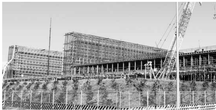
▲工事の進むイケア弥富物流センター
