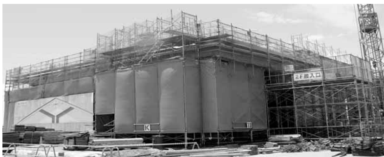
▶建設の進む新弥富中学校校舎（鎌島地内）
