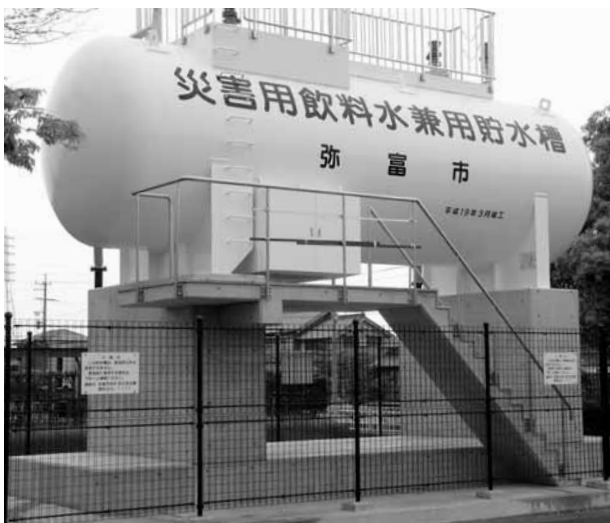
▶十四山支所敷地内に設置された災害用飲料水兼用貯水槽
