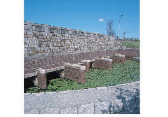
明治時代に輪中の排水に苦慮した立田輪中普通水利組合は、木曾三川改修工事の行われた明治35年にこの堰門を完成させた。しかし、排水の効果は十分に得られず、結局、役場を使って排水することになった。その後は用水の取水に利用されたが、海部幹線水路の完成により遊休堰門となつた。立田輪中の好意により旧弥富町が権利を受け継ぎ、水利史の遺跡として輪中公園の中に保存している。
