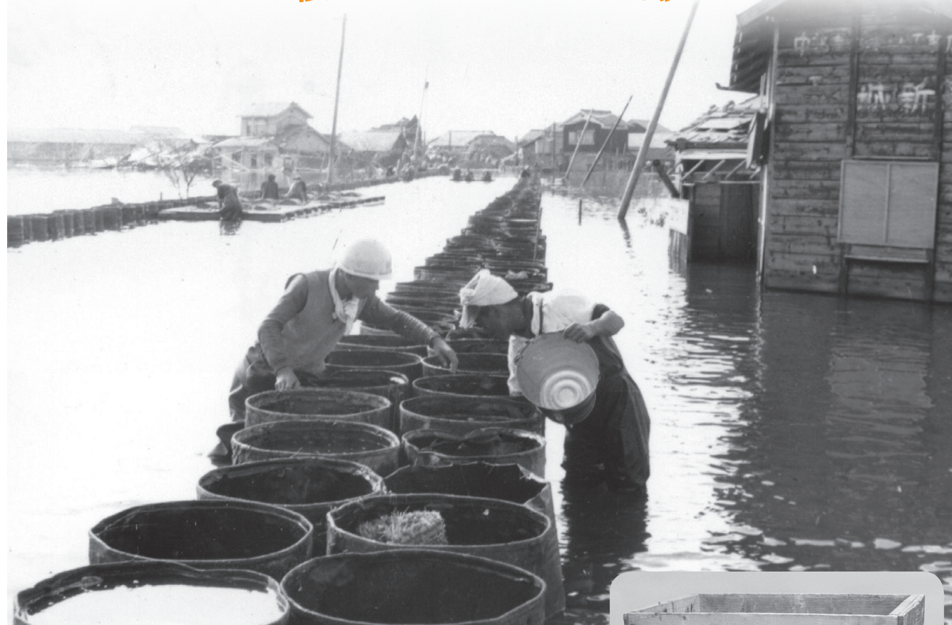
国道1号の復旧工事
