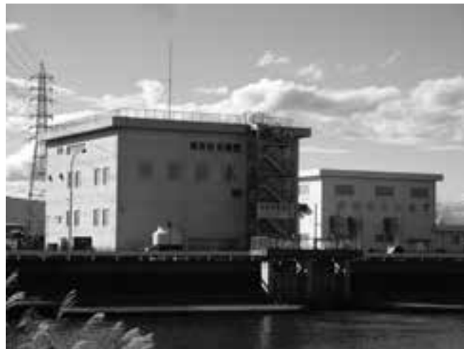
▲孫宝排水機場（津波避難階段設置済）
