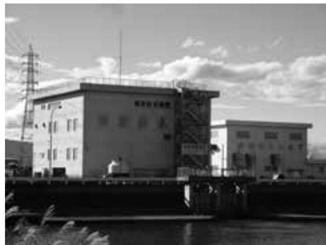
▲孫宝排水機場（津波避難階段設置済）
