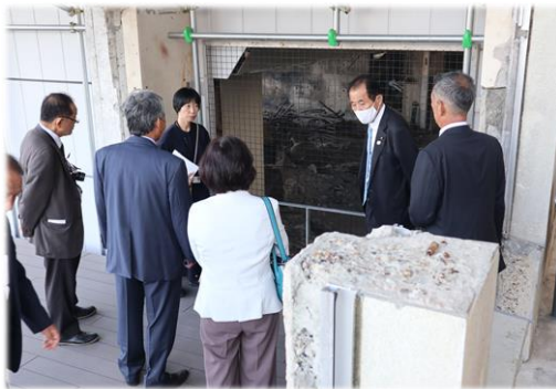
本校舎（外部通路）
