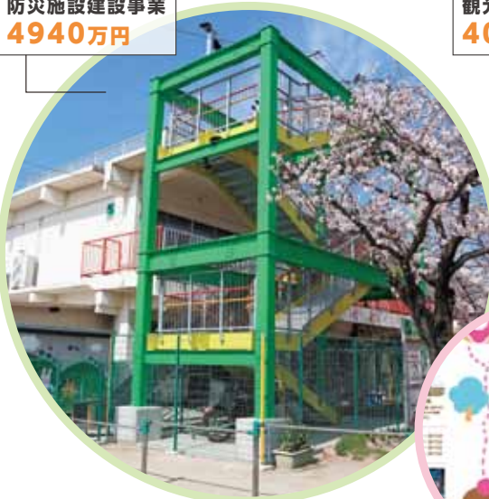
↑桜保育所の屋外避難階段と防護柵の整備
