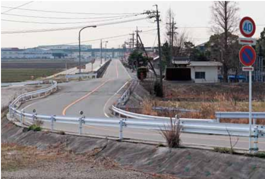
▲市道鍋田23号線道路改良工事の現場より
