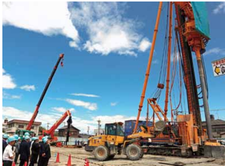
▲新庁舎建設現場（前ヶ須町地内）
