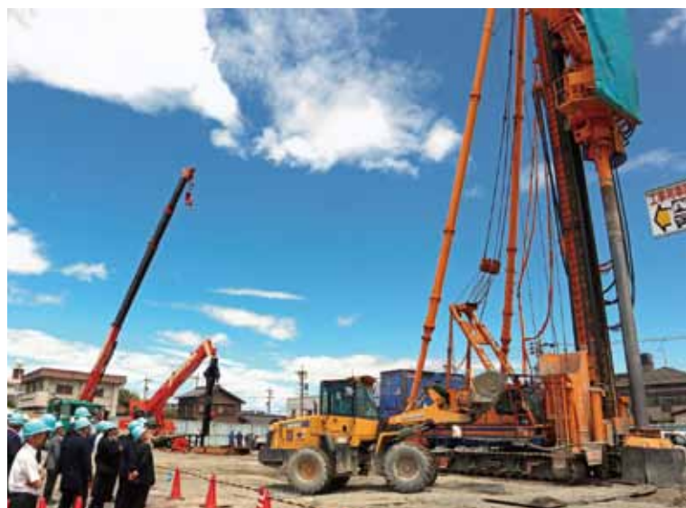
▲新庁舎建設現場（前ヶ須町地内）
