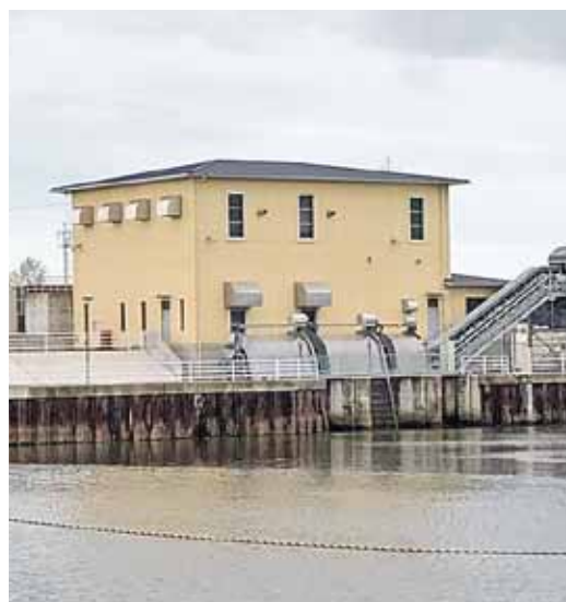
▲地域の命綱となる排水機場 (鍋田南部排水機場)
