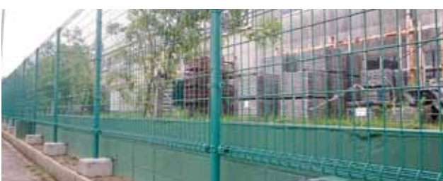
▲ブロック塀を撤去し、フェンスを設置（白鳥小学校）
