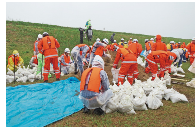
土のう作り・土のう積み訓練
