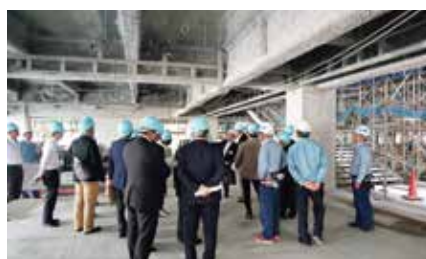
▲庁舎下層階では耐火被覆工事などを施工中
