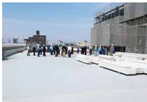
▲庁舎西側の立体駐車場の屋上(3階)
