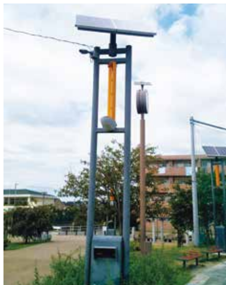
▲ソーラー照明灯など防災設備が整備されている「ひので公園」
