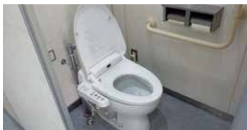
▲洋式化された小学校のトイレ
