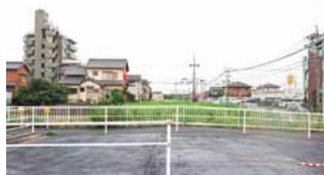
▲名古屋第3環状線前ヶ須地内
