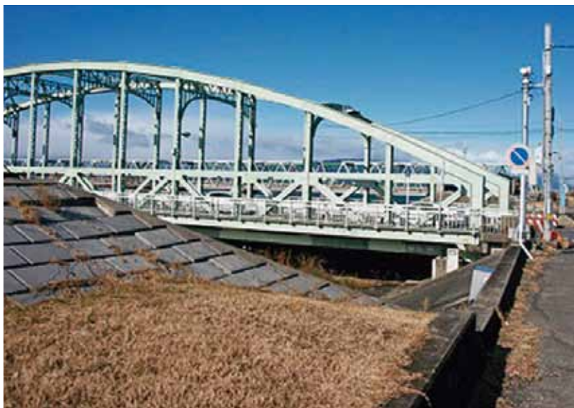
▲尾張大橋堤防付近
