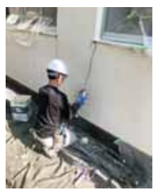
▲小学校の修繕工事
