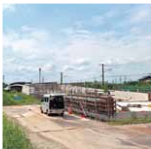
▶工事中の県道弥富名古屋線（又八地内）
