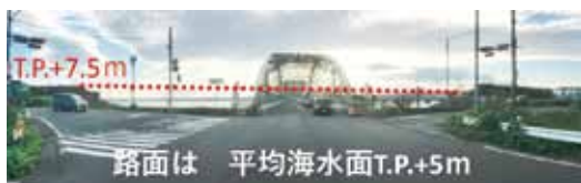
▲国道1号 尾張大橋
