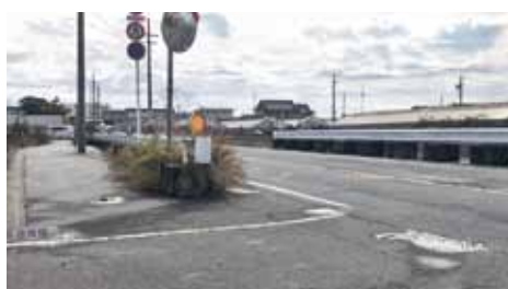
▲寛延地内鋳物工場付近(未整備区間)
