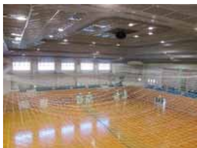
▲十四山スポーツセンターの天井
