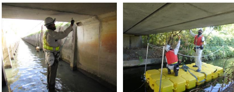
図：橋梁点検の様子
