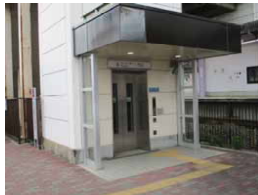
近鉄弥富駅南口 エレベーター
