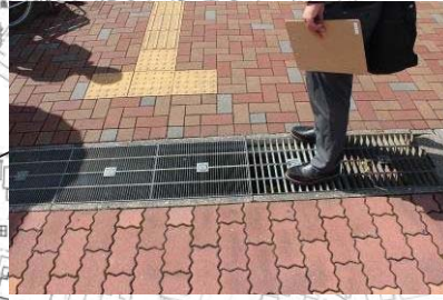
・細目グレーチング蓋（左） ・溝幅が広いグレーチング蓋
