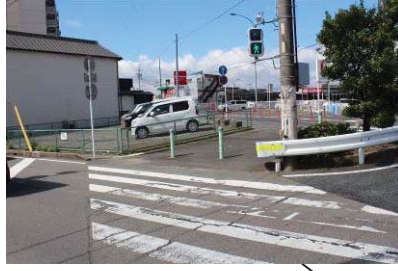
・音響信号はあるものの、視覚障害者誘導用ブロックはない
