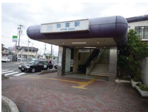
エスカレーター（北口）
