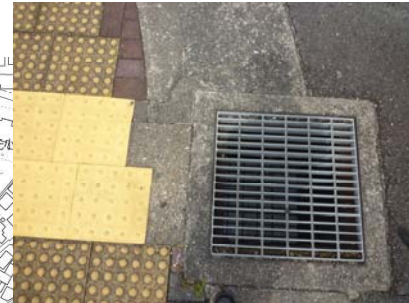
・溝幅の広いグレーチング蓋
